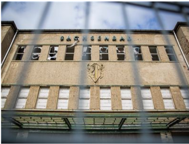
Zutritt verboten: Heute ist das Sachsenbad an der Ecke Wurzenener/Rehefelder Straße verfallen.
